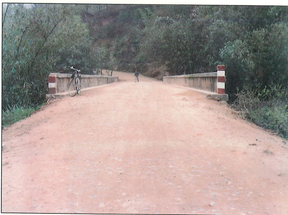
外碧通內碧大橋
